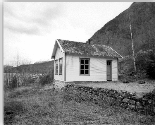
Bilete: Skulehuset i Vindedalen
