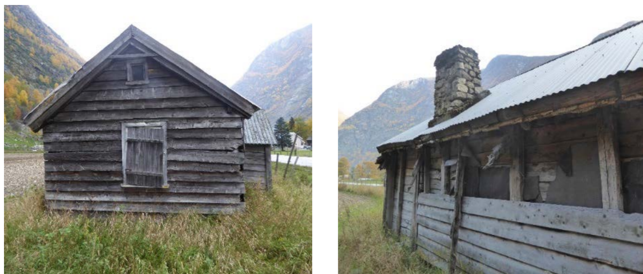
Figur 13. Pikarhuset er den einaste husmannsstova som er att på Nedre Eri. Foto: Eli Mundhjeld, SVV 2018.
