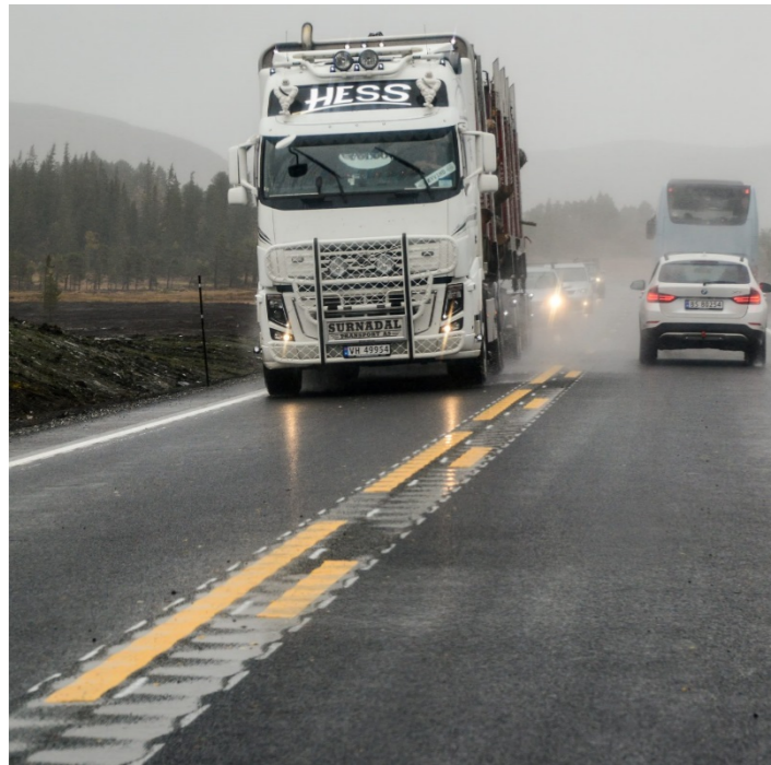
Figur 25 Døme på forsterka midtoppperking med sinusfresing
