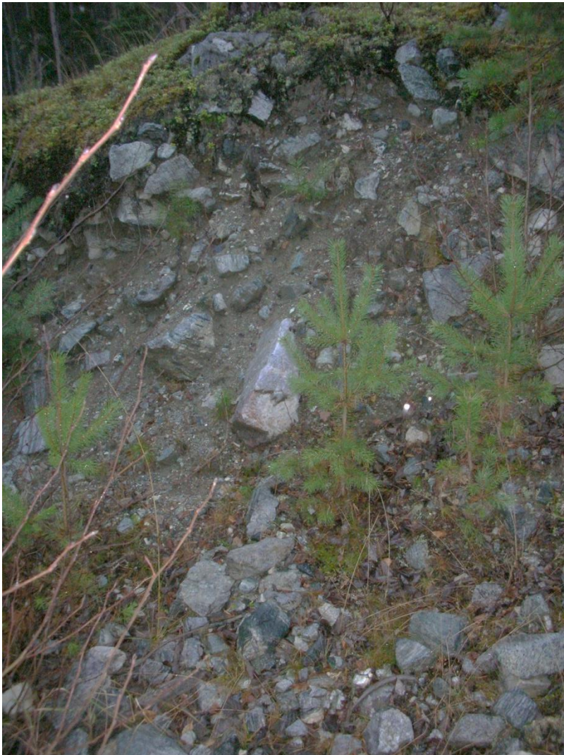
Fig. 3 Jordskredavsetning (WP 148) fra kanalvegg i skredrenne. Typisk er en matriksbåret struktur der blokkene ligger omkranset av finere materiale.
