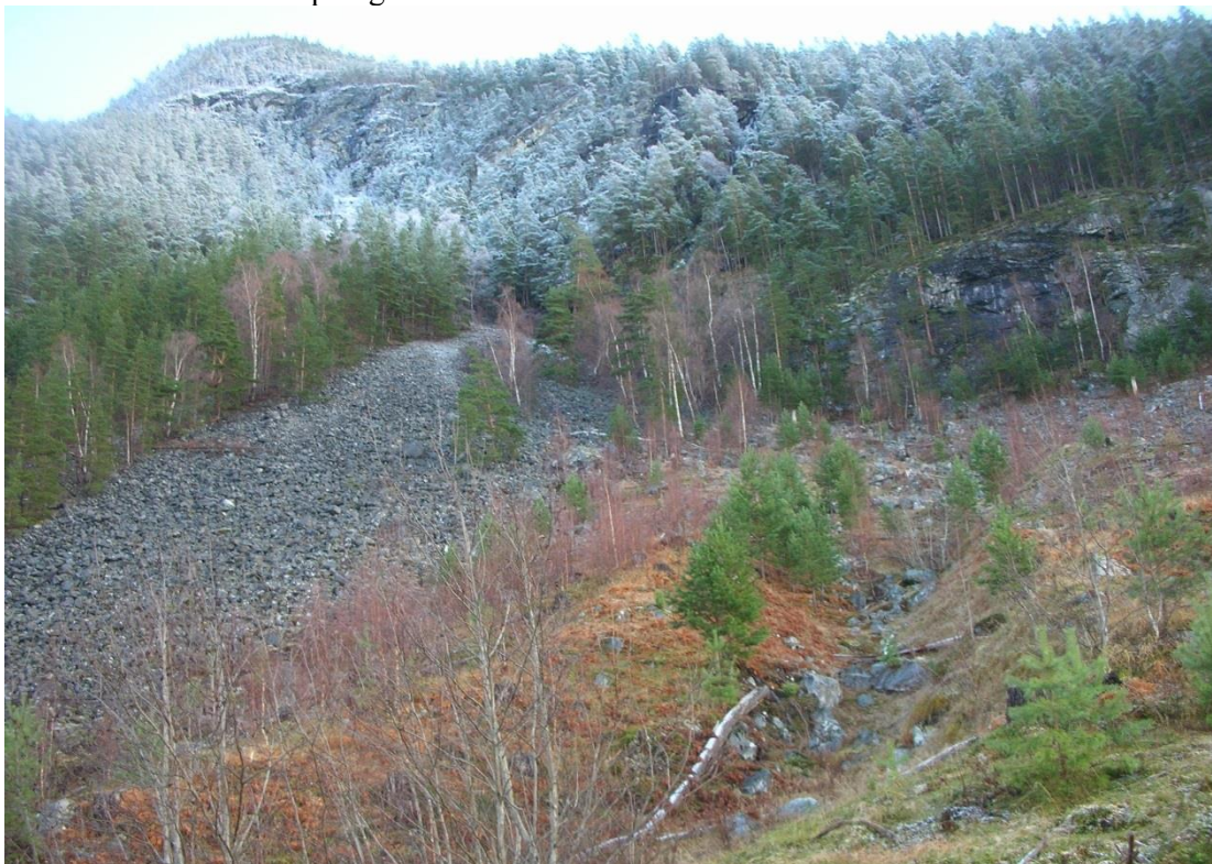
Fig. 12 Øvre brattkant med steinsprangur. Legg merke til skredrennen til høyre. Opprinnelig barskog i dette området er fjernet ved hogst.
